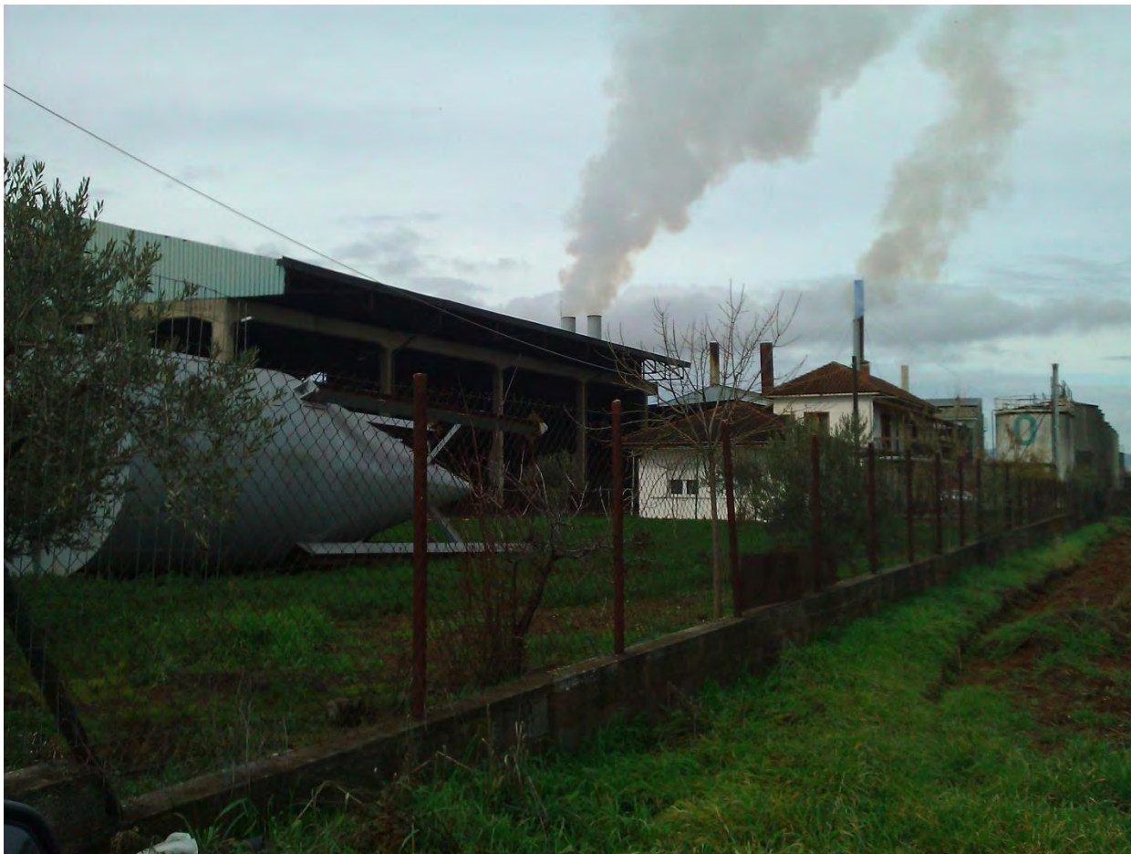
Εικόνα 9: Εγκαταστάσεις εργοστασίου ΕΛΑΙΟΥΡΓΙΑ ΜΑΓΝΗΣΙΑΣ - ΜΙΧΑΗΛ ΚΟΥΦΑΚΗΣ Α.Ε.. στην περιοχή του Αλμυρού (Βορειοανατολική όψη)
