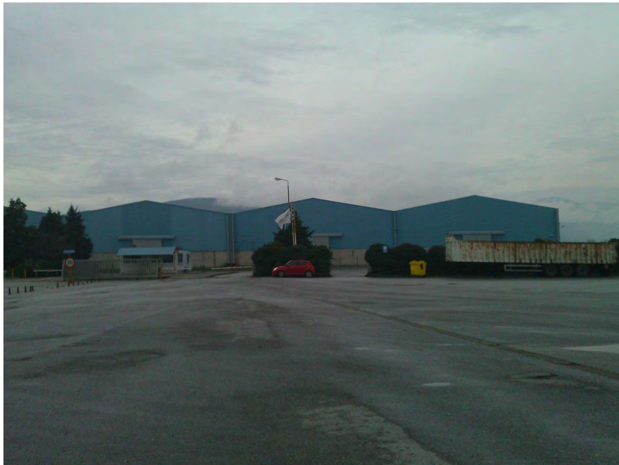
Εικόνα 7: Εγκαταστάσεις εργοστασίου ΣΙΑΕΝΟΡ Α.Ε. στην περιοχή του Αλμυρού (Βόρεια όψη)
