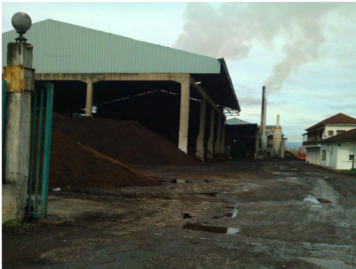
Εικόνα 8: Εγκαταστάσεις εργοστασίου ΕΛΑΙΟΥΡΓΙΑ ΜΑΓΝΗΣΙΑΣ - ΜΙΧΑΗΛ ΚΟΥΦΑΚΗΣ Α.Ε.. στην περιοχή του Αλμυρού (Ανατολική όψη)
