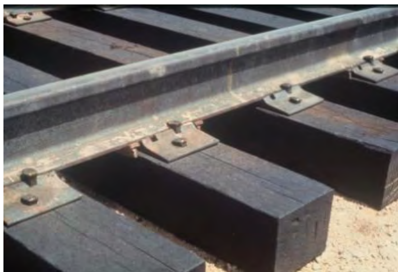
Εικόνα 2: Στρωτήρες σιδηροτροχιάς από ξύλο
