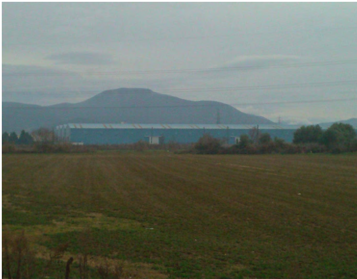
Εικόνα 6: Εγκαταστάσεις εργοστασίου ΣΙΑΕΝΟΡ Α.Ε. στην περιοχή του Αλμυρού (Δυτική όψη)
