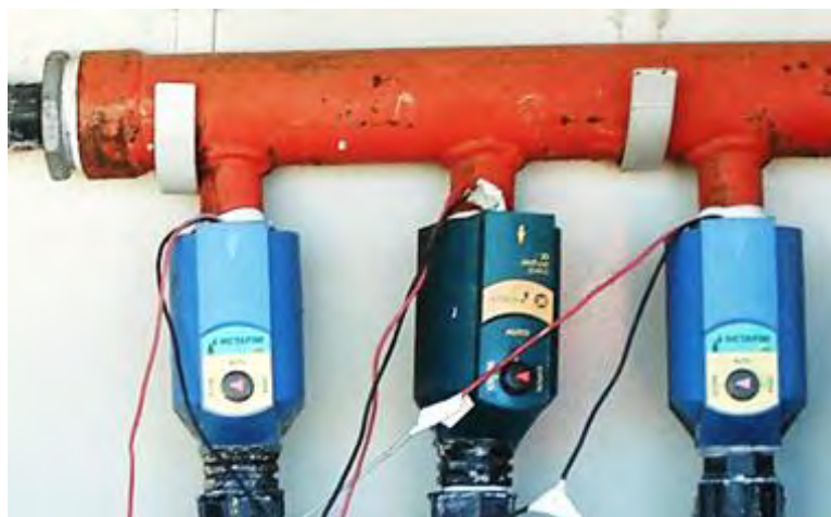
Εικόνα 5.9. Ηλεκτροβάνες.
