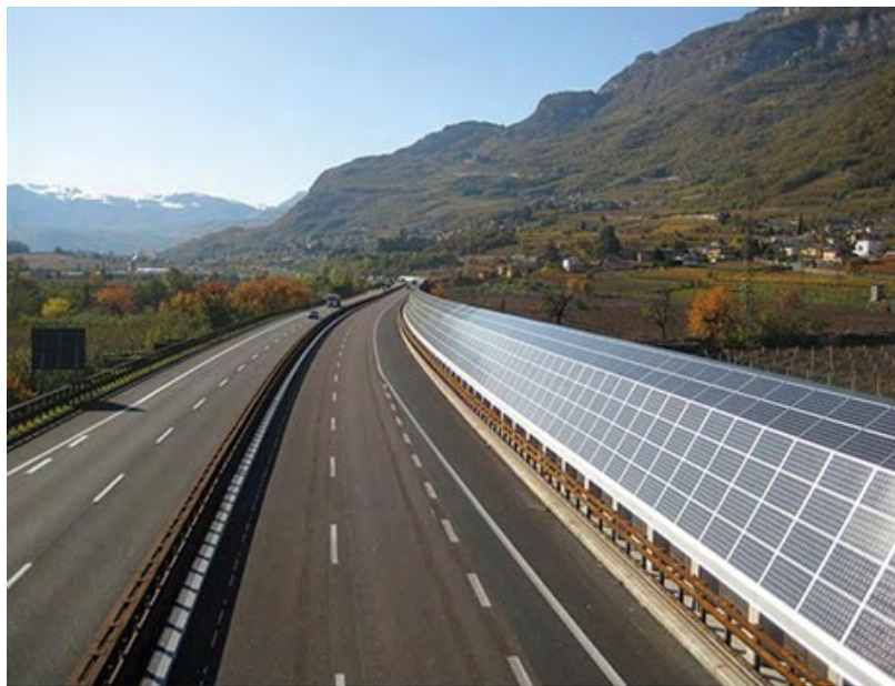
Εικόνα 3-Εγκατάσταση PVBS στην ταλία( http://www.worldhighways.com / ).
