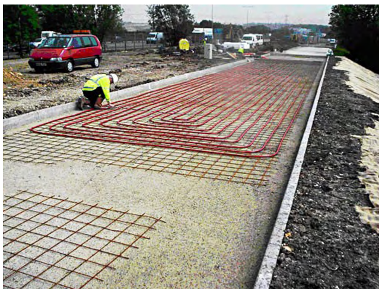
Εικόνα 2-Εφαρμογή Συστήματος Σωληνώσεων σε Οδόστρωμα ( http://www.icax.co.uk ).
