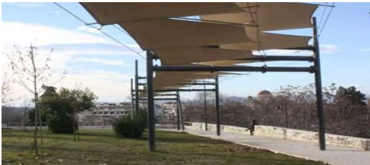
Εικόνα 79: Παραδείγματα αστικού εξοπλισμού που εγκαταστάθηκε στη πόλη της Λάρισας για τη ρύθμιση των συνθηκών θερμικής άνεσης (1)
