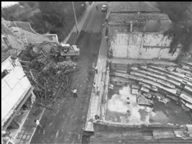
1992 κατεδαφίσεις επί της οδού Παπαναστασίου
