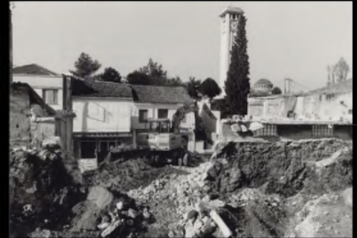
1980 κατεδαφίσεις επί της οδού Παπαναστασίου
