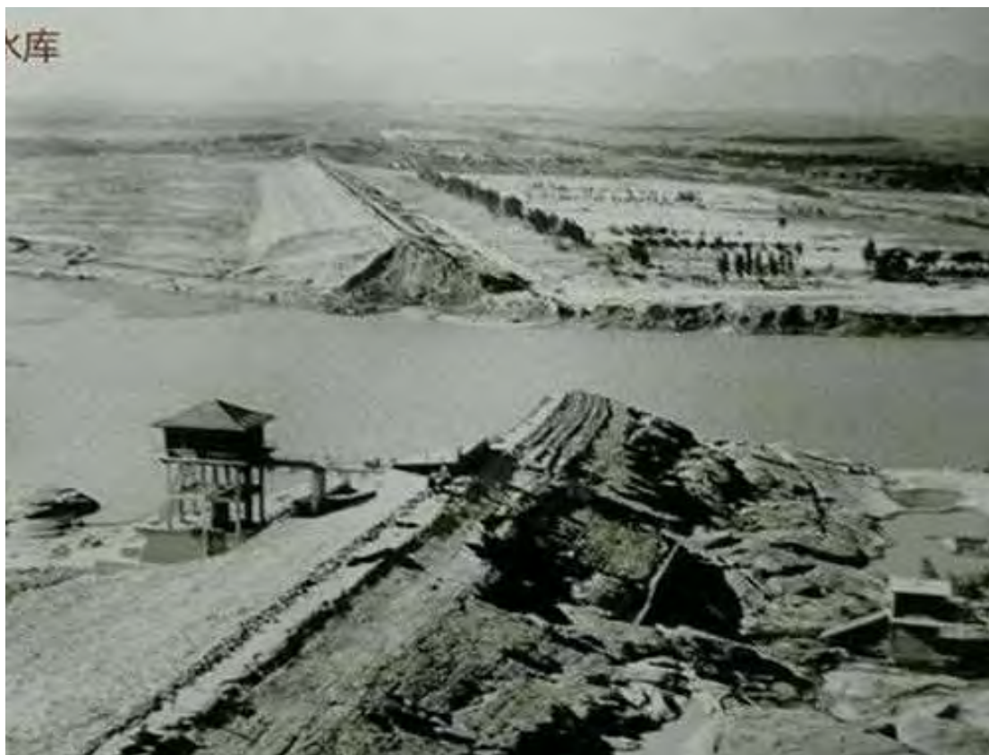
Εικόνα 1.5: Φωτογραφία του φράγματος Banqiao μετά την αστοχία (πηγή: http://www.mnn.com )
