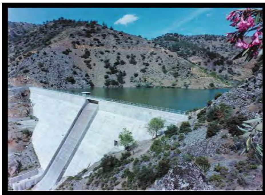
Εικόνα 1.1: Φράγμα βαρύτητας από σκυρόδεμα στην επαρχία Παλαιχώρι – Καμπί, Λευκωσία Κύπρου (πηγή: http://www.jandpcy.com/el/Palekhor-i-Kampi-Dam-gr )
