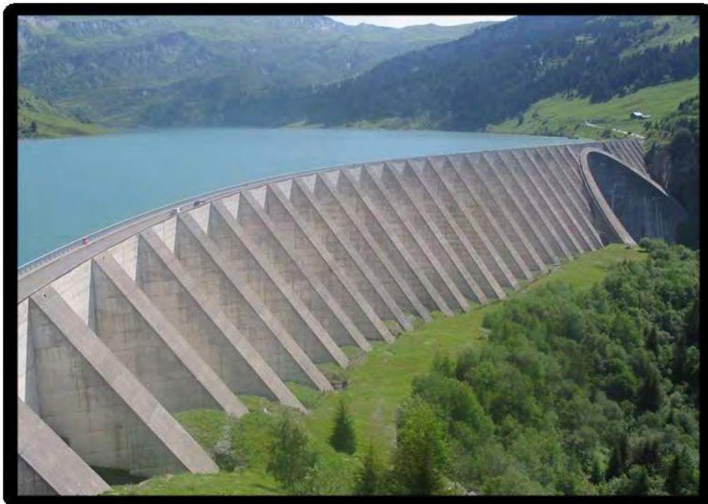
Εικόνα 1.5: Αντηριδωτό φράγμα στο Roselend, Γαλλία (πηγή: https://en.wikipedia.org/wiki/Roselend_Dam )
