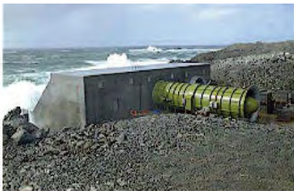
Εικόνα 4.10α Παράκτιος σταθμός παραγωγής
