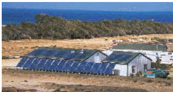
Εικόνα 4.3 Απομακρυσμένη εγκατάσταση παραγωγής ηλεκτρικής ενέργειας
