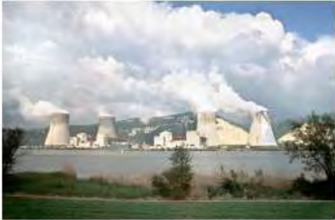
Εικόνα 2: Πυρηνικό εργοστάσιο στη Γαλλία
