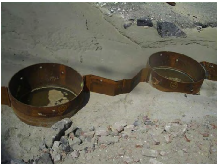
Εικόνα 1.2 Παράδειγμα συνδυσμένου συστήματος τοίχων υπό κατασκευή [7].
