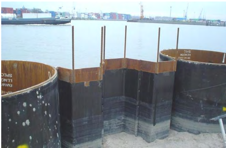
Εικόνα 3.1 Παράδειγμα σύνθετου τοιχίου υδατοφράγματος
