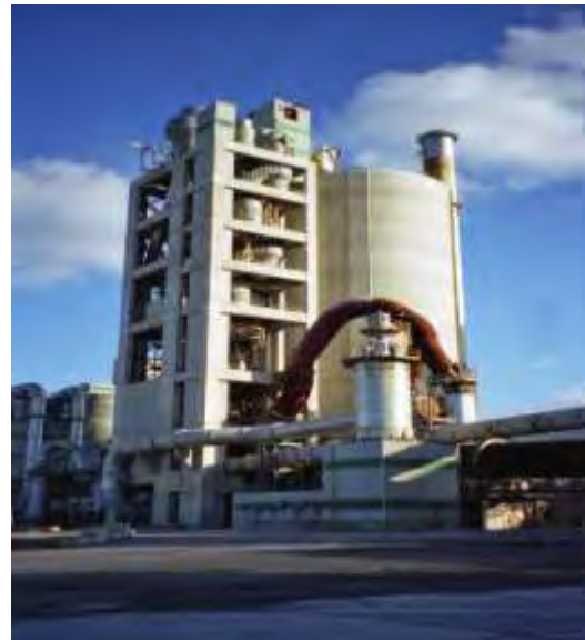
Εικόνα 2-4: Πύργος με συστοιχία προθερμαντήρων 4 σταδίων, σιλό αποθήκευσης πρώτων υλών και αεραγωγός εξαγωγής καυσαερίων [19]
