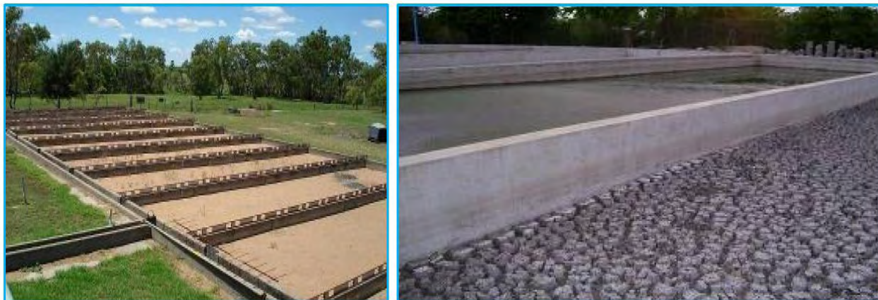
Σχήμα 3.34: Κλίνες ξήρανσης (ΠΗΓΗ: Νταρακάς, 2010)
