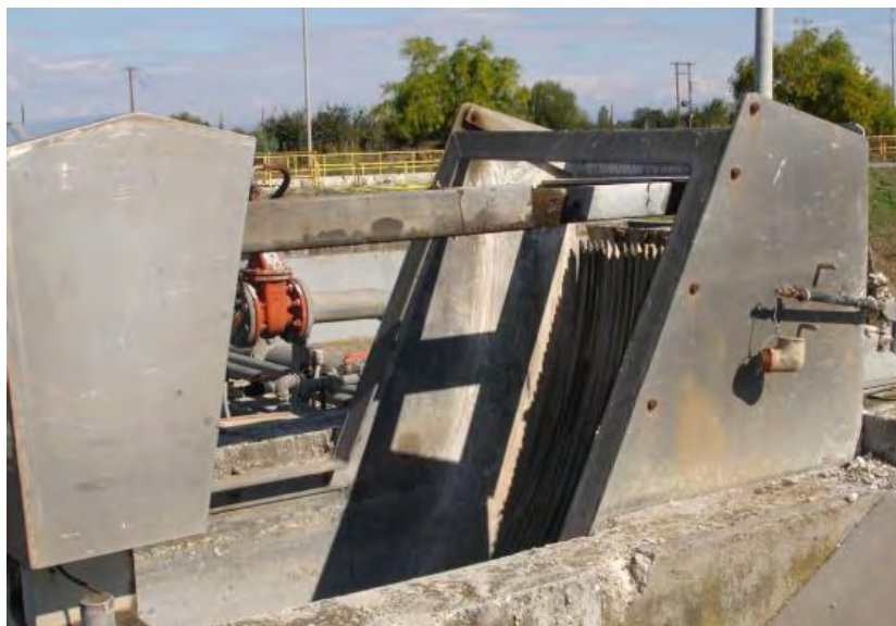
Σχήμα 4.2: Φωτογραφία της μηχανοκίνητης τοξωτής εσχάρας
