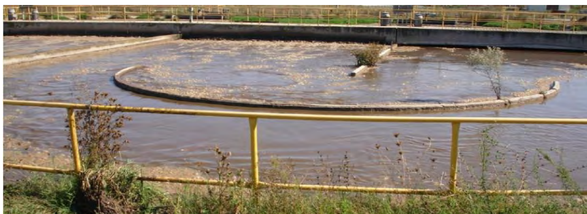
Σχήμα 4.5: Φωτογραφία επιφάνειας οξειδωτικής τάφρου εισόδου-εκροής
