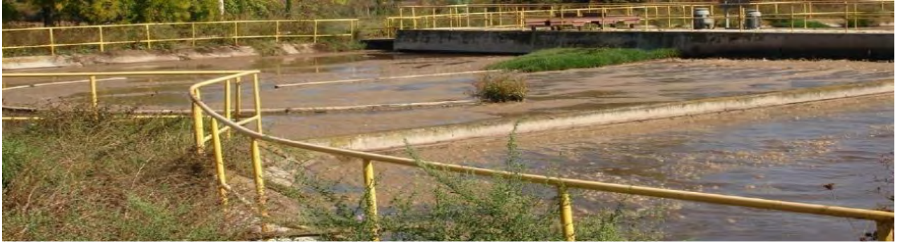
Σχήμα 4.6: Φωτογραφία επιφάνειας των 2 οξειδωτικών τάφρων με τους αεριστές στο βάθος
