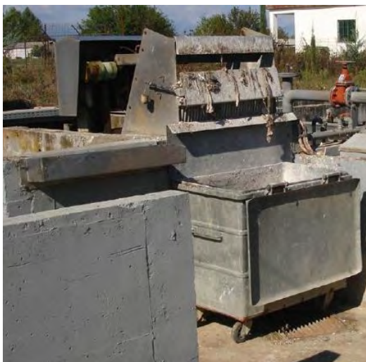
Σχήμα 4.3: Φωτογραφία κάδου αποθήκευσης εσχαρισμάτων
