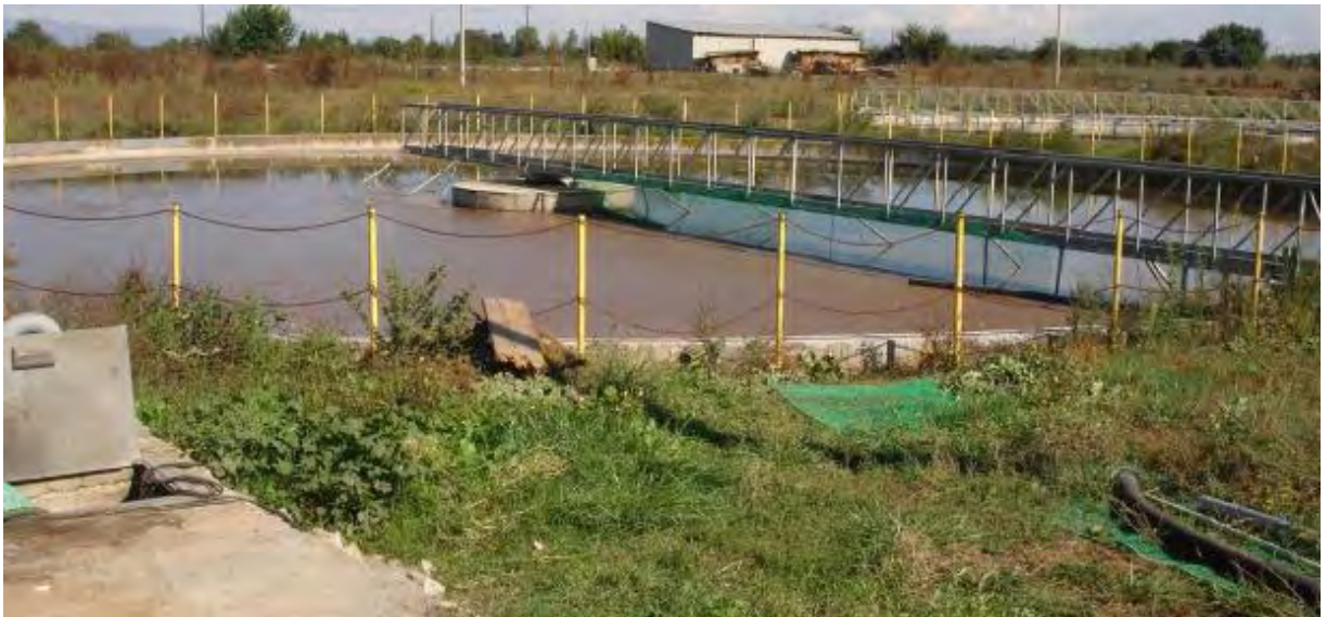
Σχήμα 4.7: Φωτογραφία Δεξαμενής Τελικής Καθίζησης
