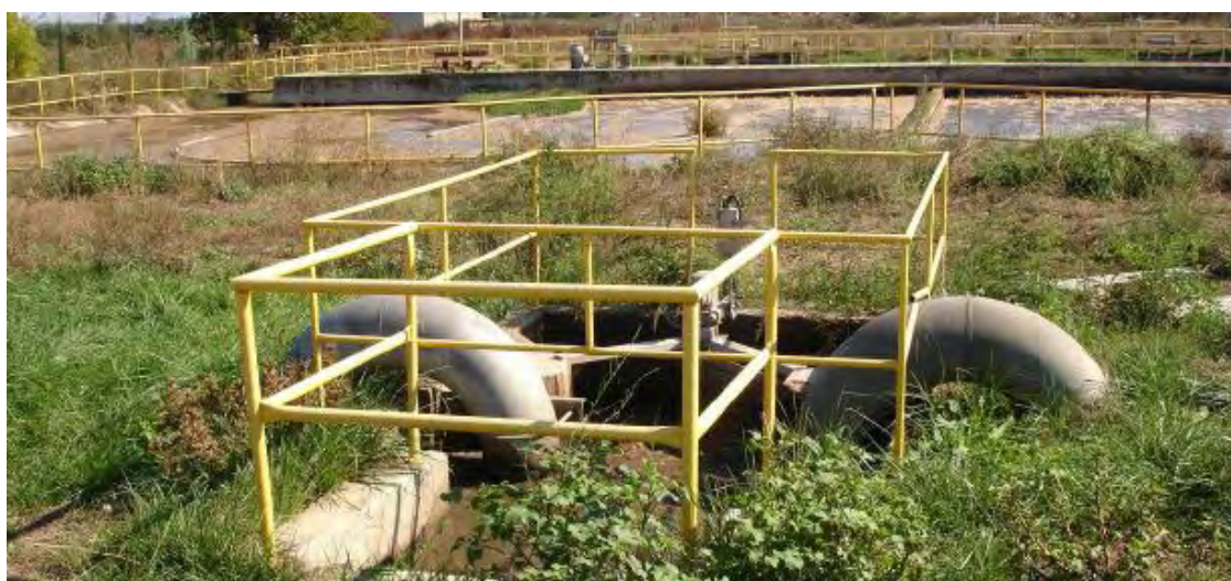
Σχήμα 4.9: Φωτογραφία Φρεάτιου Διανομής-Ανακυκλοφορίας της λάσπης στις οξειδωτικές τάφρους
