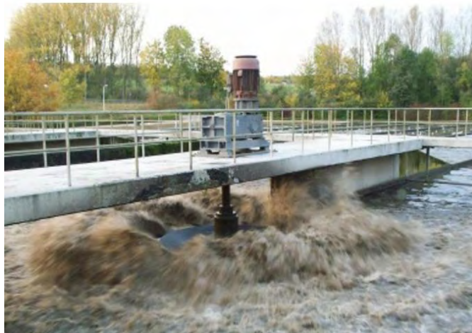
Σχήμα 3.27: Επιφανειακός αεριστήρας με φτερωτή τύπου O 2 max (ΠΗΓΗ: ΜΙΧΟΣ Α.Ε.)
