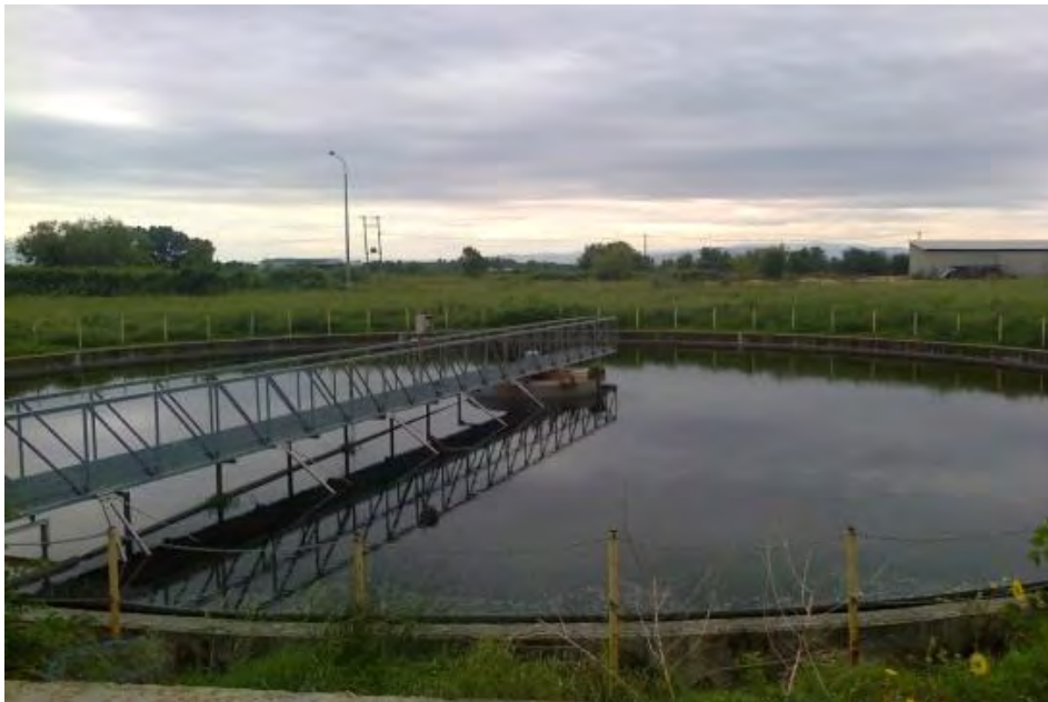
Σχήμα 5.12: Περιστρεφόμενο ξέστρο δεξαμενής καθίζησης
