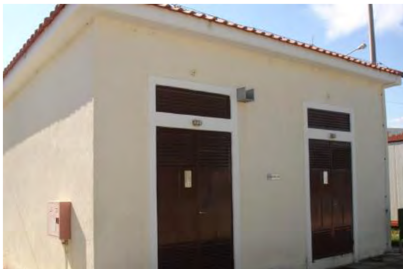
Σχήμα 4.16: Φωτογραφία Κτιρίου Υποσταθμού Η/Ζ
