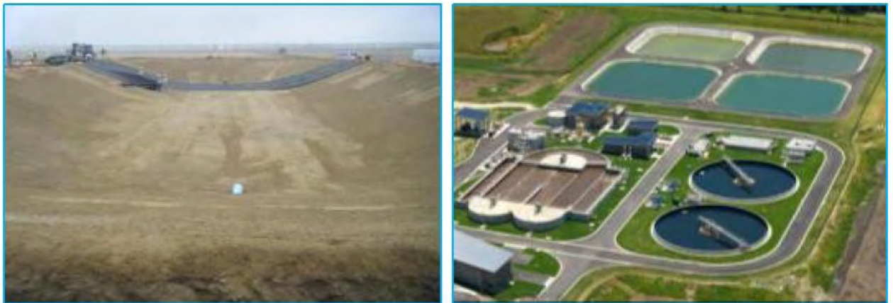
Σχήμα 3.16: Λίμνες-Δεξαμενές σταθεροποίησης (ΠΗΓΗ: Νταρακάς, 2010)
