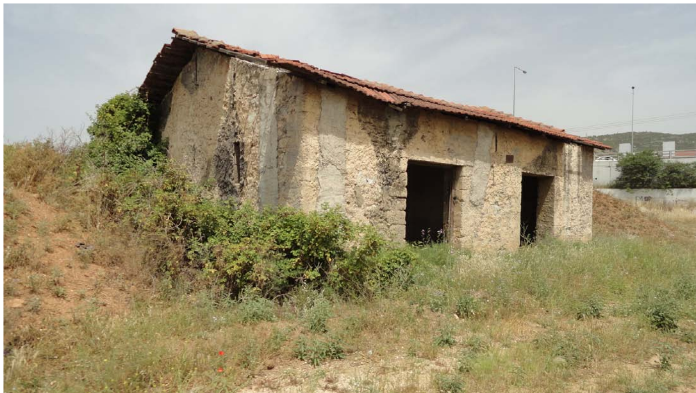
Εικόνα 16. Κτίριο αποθηκών στο κεντρικό τμήμα
