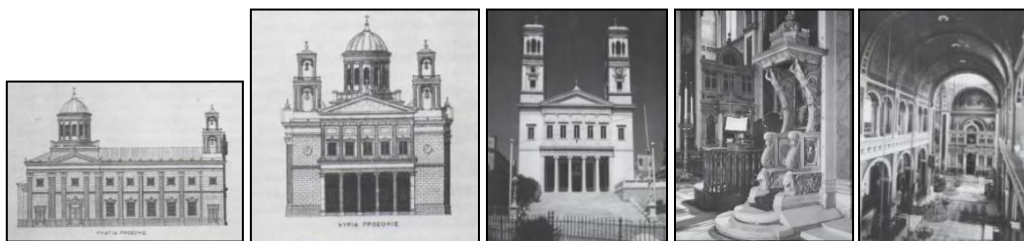
Εικόνες 150-154. Παλιές χαλκογραφίες του Αγ. Νικολάου (1848), εξωτερική όψη του ναού, επισκοπικός θρόνος & εσωτερικό του ναού.
