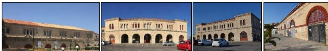
Εικόνες 231-234. Πινακοθήκη Κυκλάδων & αποθήκες διαμετακομίσεως σήμερα. Πηγή: Προσωπικό αρχείο.
