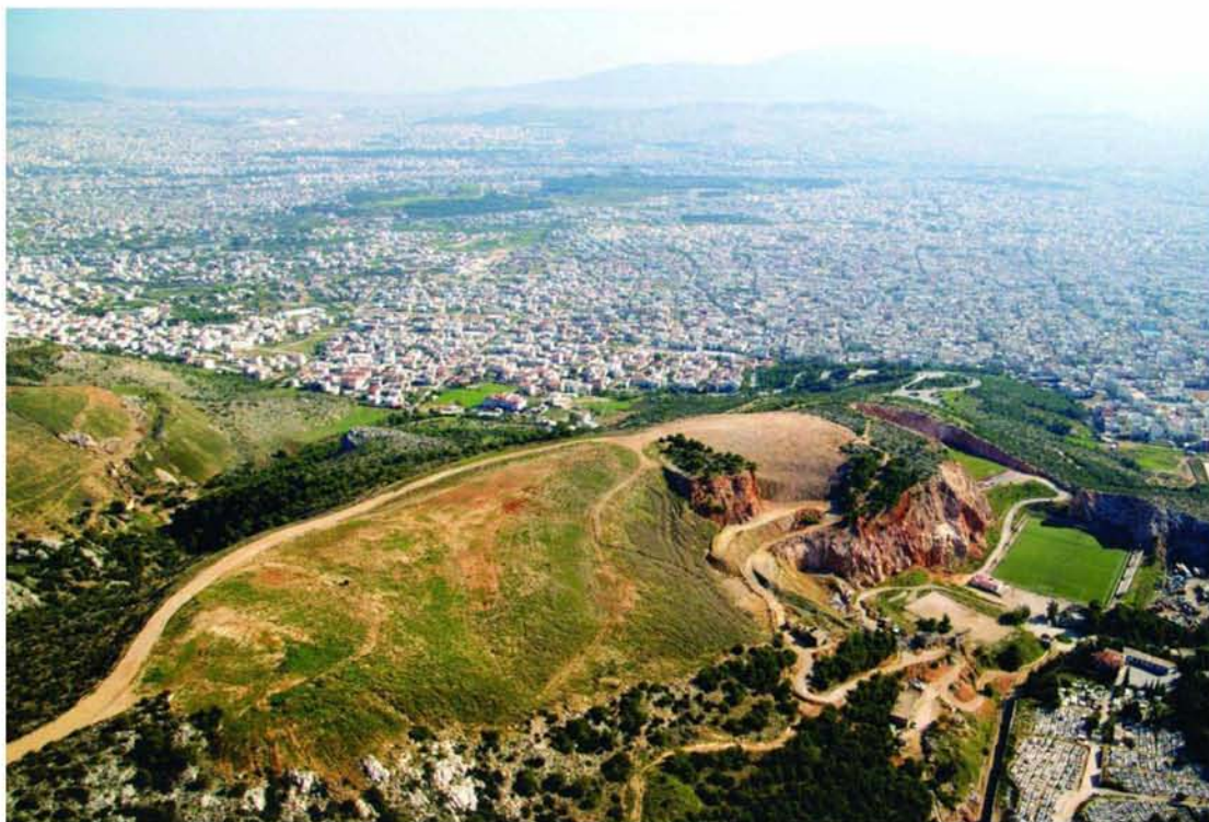
Εικόνα 4 Αποκατάσταση λατομείου Πετρούπολης. Πηγή Άκτωρ κατασκευαστική
