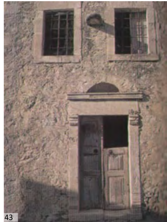
41-43. Καλοδουλεμένα λαξευτά πέτρινα πλαίσια τονίζουν τα ανοίγματα στη λαϊκή κρητική αρχιτεκτονική.
