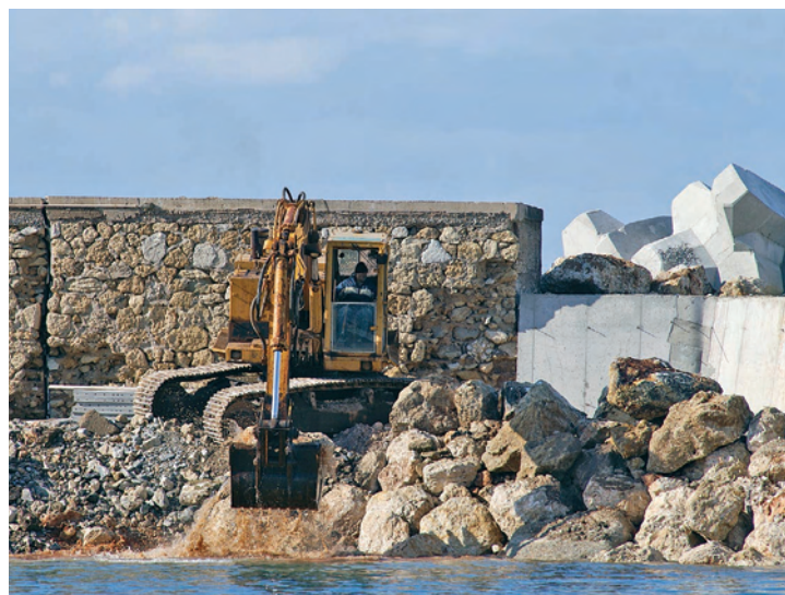
εικόνα_10 Στιγμιότυπο από τη κατασκευή του προσήνεμου μώλου.
