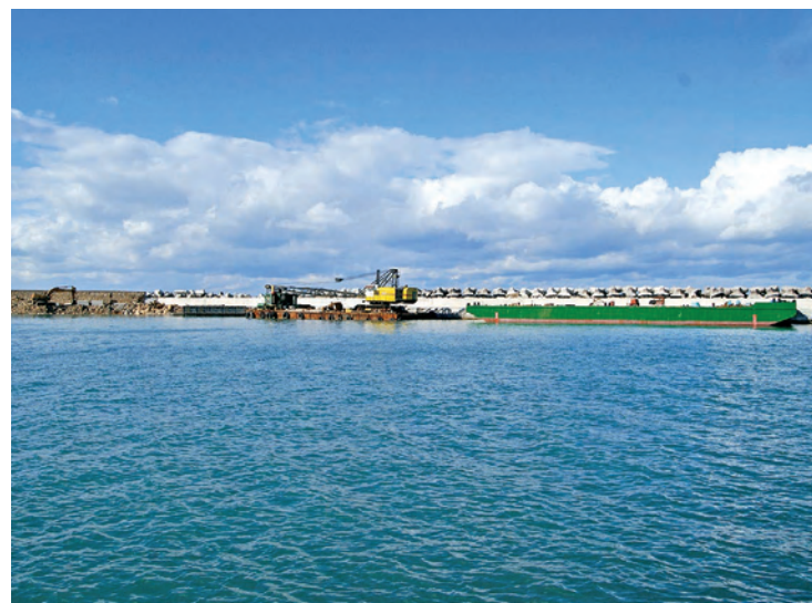
εικόνα_11 Στιγμιότυπο από τη κατασκευή του προσήνεμου μώλου.
