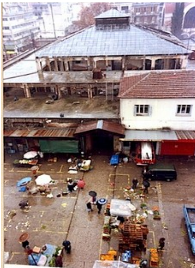
Εικόνα 8. Το κτίριο της δημοτικής αγοράς πριν την αποκατάσταση (Πηγή: http://www.dimoskarditsas.gov.gr/?page_id=3258 )
