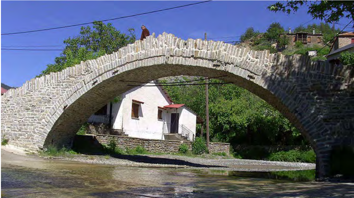
Εικόνα 41. Η νότια όψη του γεφυριού στο Δοτσικό. Το μοναδικό εντός οικισμού
