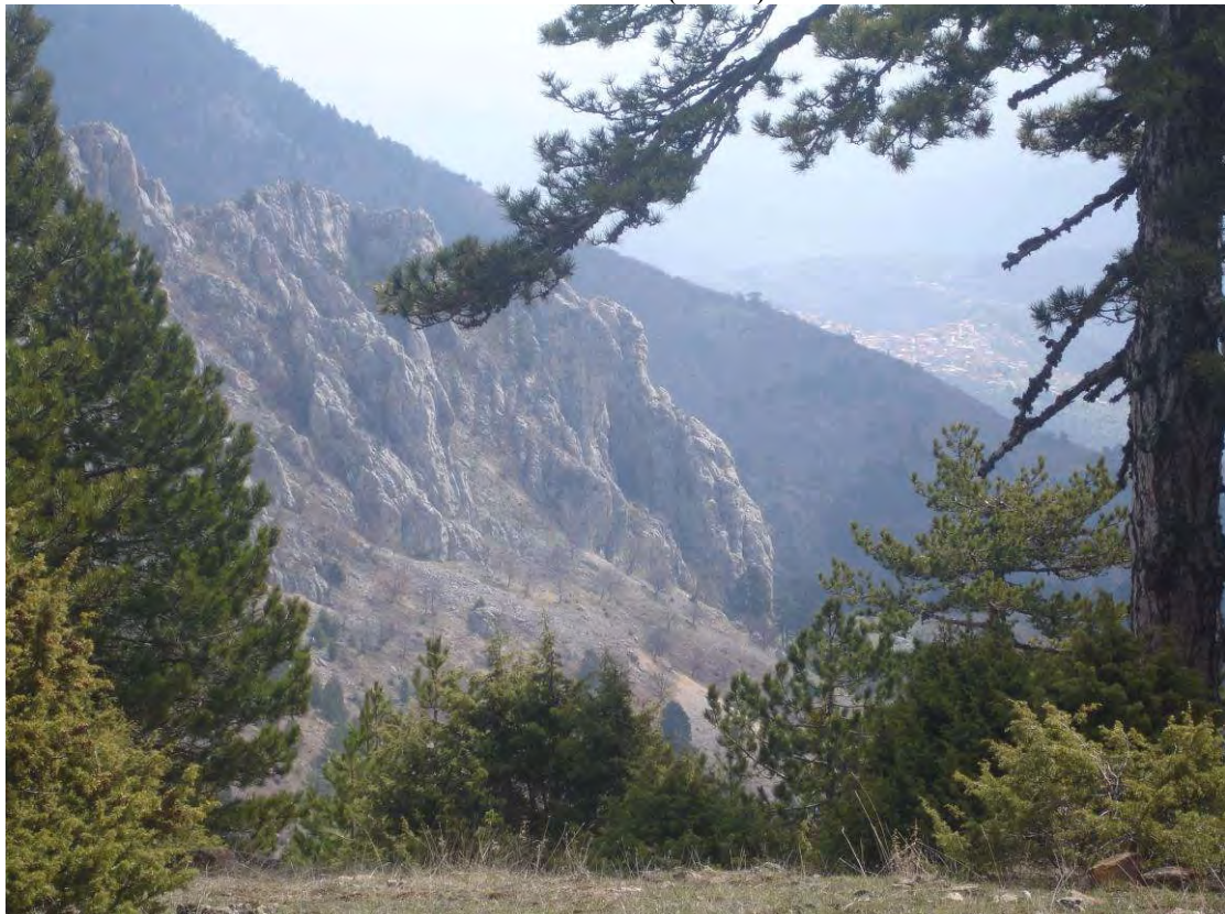
Εικόνα 64. Νοτιοανατολική θέα από τη θέση τοποθέτησης του κτιρίου ενδιατημάτων του υπο κατασκευή ΕΑΠΟ (διακρίνονται οι βραχώδεις εξάρσεις του Όρλιακα και ο οικισμός του Σπηλαίου στο βάθος)
