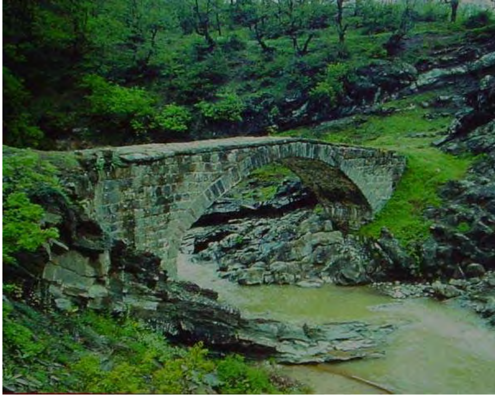
Εικόνα 42. Η ανατολική όψη του γεφυριού στο Νιδρούζι
