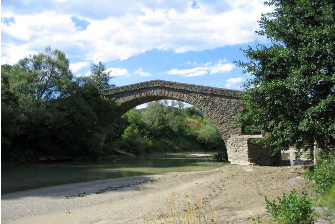
Εικόνα 38. Η βόρεια όψη του γεφυριού του Ζιάκα στο Βελόνια ποταμό
