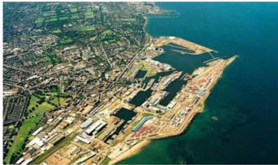
Αεροφωτογραφία της περιοχής
