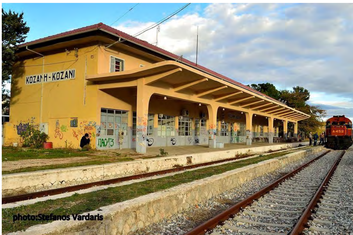
Εικόνα 29: Επιβατικός σιδηροδρομικός σταθμός της πόλης της Κοζάνης
