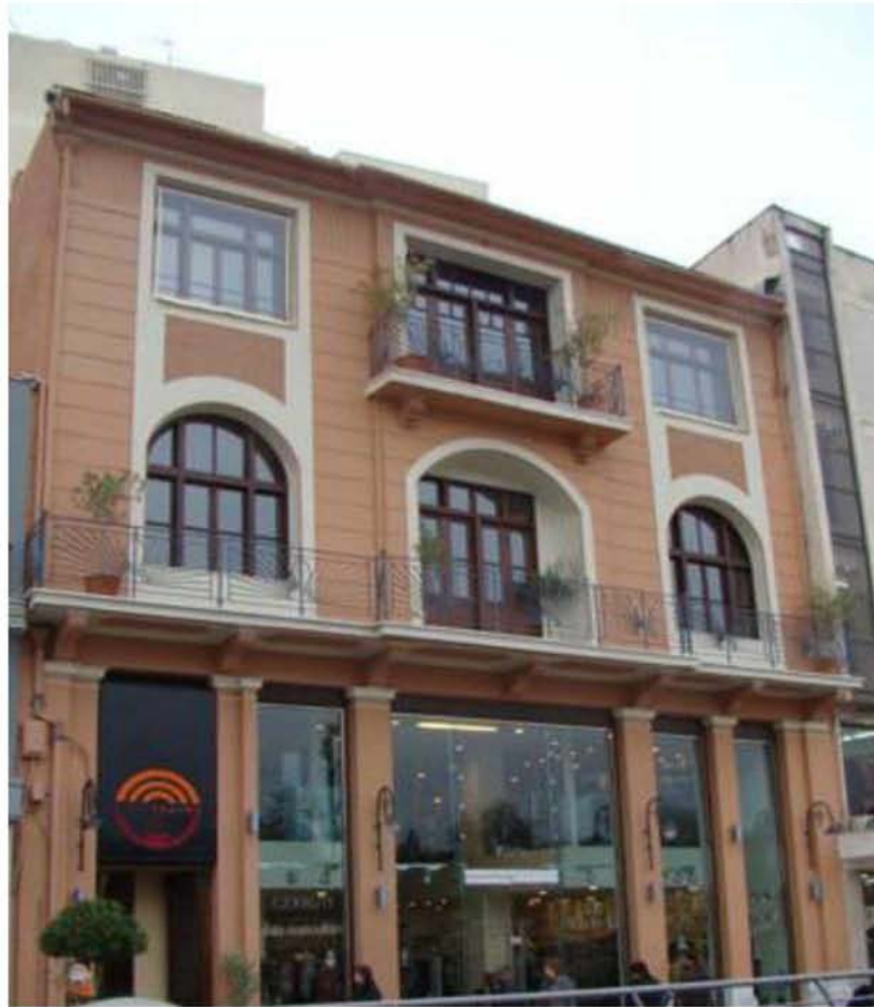
Εικόνα 53: Κτίριο επί της οδού Βενιζέλου
