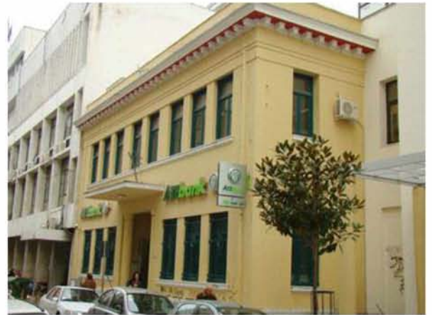
Εικόνα 56: Κτίριο επί της οδού Ι. Δραγούμη
