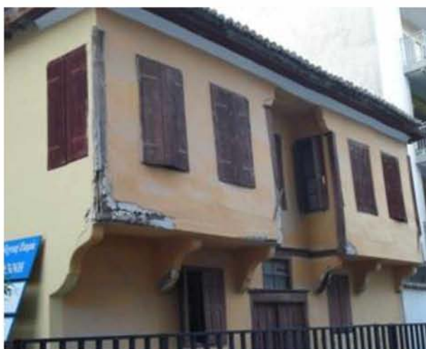
Εικόνα 51: Κτίριο οδού Σεφέρη
