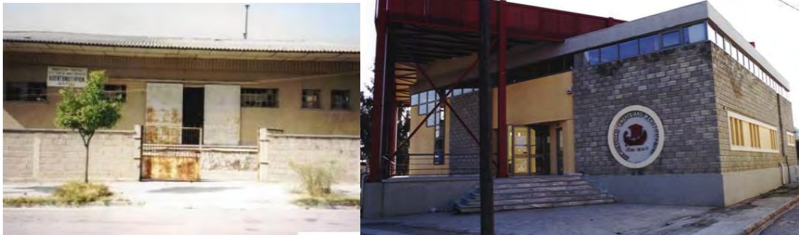
Εικόνες 3.31 και 3.32: Περιφερειακό Ενεργειακό κέντρο Θεσσαλίας και ANEBO πρώην απεντομωτήριο (δεξιά: επανάχρηση κτιρίου, αριστερά: πριν την επανάχρηση)
