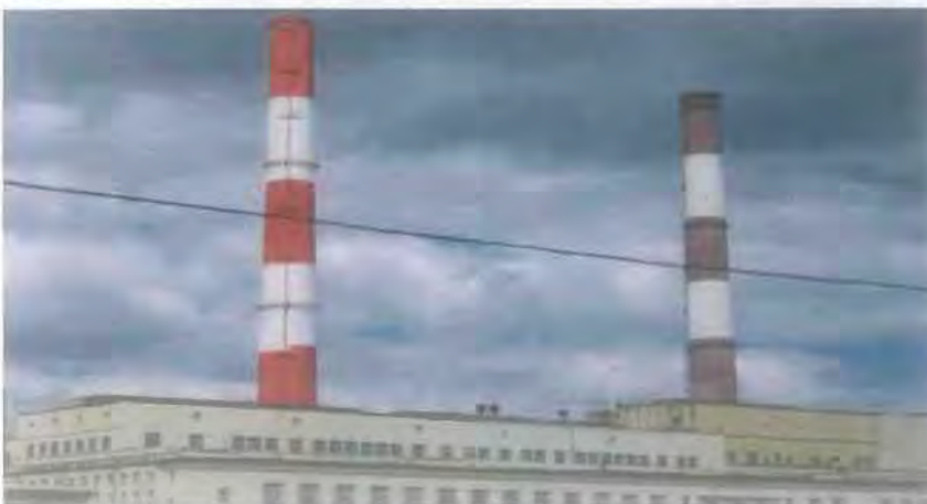
Εικόνα 28:Εργοστάσιο τηλεθέρμανσης στην Μόσχα
