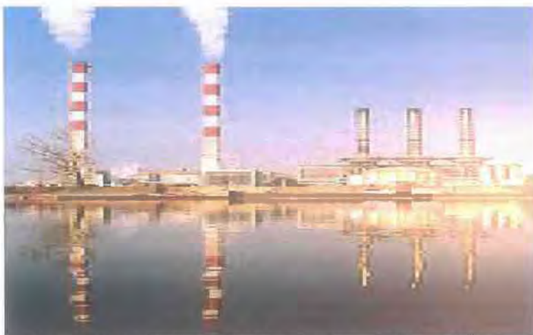
Εικόνα 29:Εργοστάσιο τηλεθέρμανσης στο Βελιγράδι
