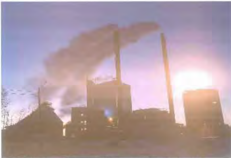
Εικόνα 22: Εργοστάσιο τηλεθέρμανσης στην Φινλανδία
