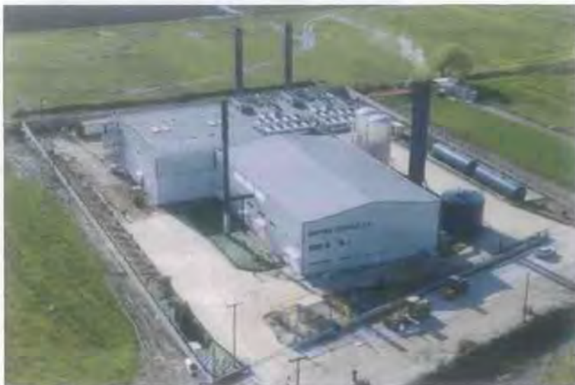
Εικόνα 36:Εργοστάσιο φυσικού αερίου στις Σέρρες
