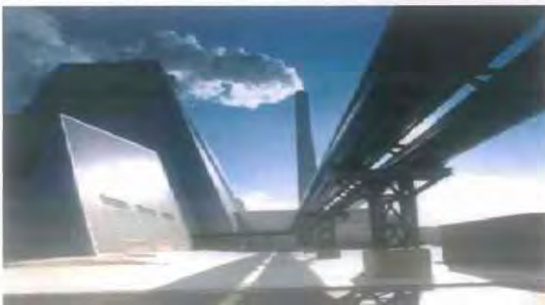
Εικόνα 20: Εργοστάσιο αποτέφρωσης καυσίμων με τηλεθέρμανση στην Κοπεγχάγη
