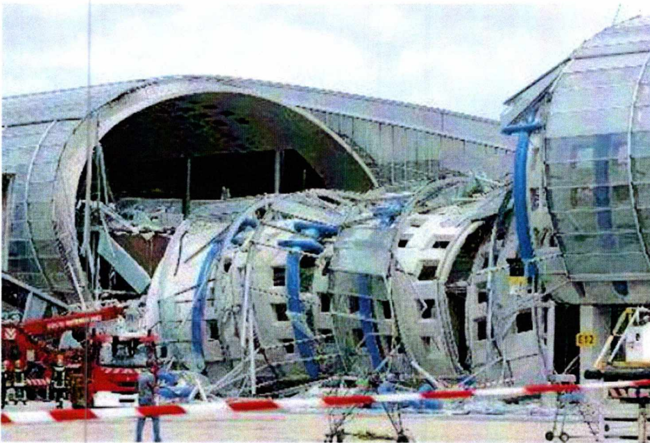
Σχήμα 1.7. Μερική κατάρρευση του Charles de Gaulle Airport Terminal, Παρίσι
