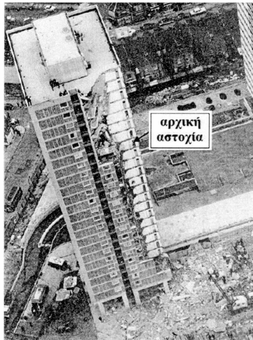
Σχήμα 1.4: Προοδευτική κατάρρευση του Ronan Point
