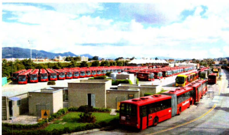
Εικόνα 7: Χώρος Στάθμευσης Λεωφορείων 5
