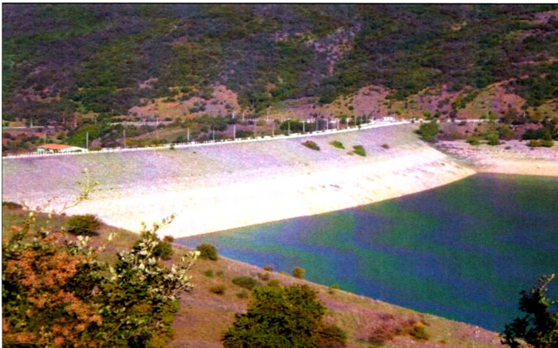
Σχήμα 1.3.4 Χωμάτινο φράγμα
