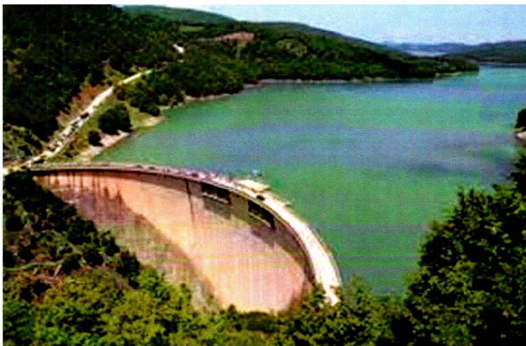
Σχήμα 1.5.1 Φράγμα Ταυρωπού (χαρακτηριστικό τοξωτό φράγμα)
