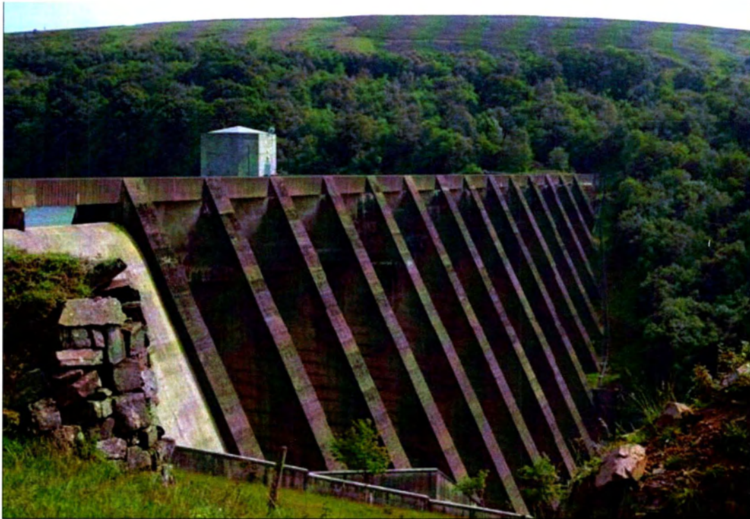
Σχήμα 1.3.3 Αντιρηδωτόφράγμα
