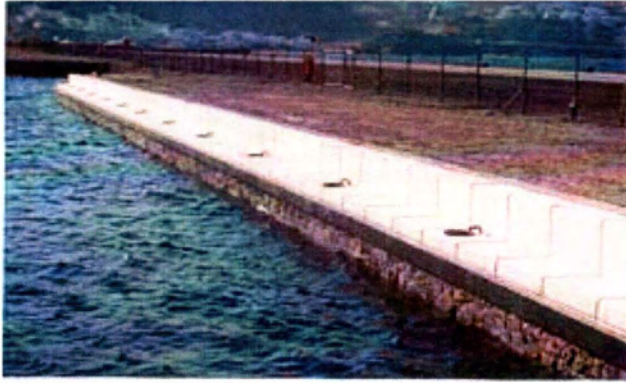
Σχήμα 1.7: Κρηπιδότοιχος σε λιμενική εγκατάσταση
