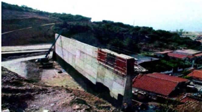
Σχήμα 1.9 : Έργο αντιστήριξης εδάφους σε ορεινό οικισμό (σε φάση κατασκευής)
