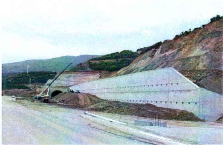
Σχήμα 1.8: Αντιστήριξη πρανούς σε έργο οδοποιίας
