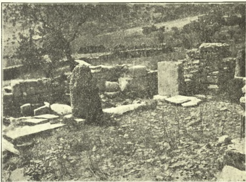
Εἰκ. 8. Κίον μεταξύ θωρακίων κατὰ τὴν νοτιὰν πλευρὰν τοῦ πρεσβυτερίου.
