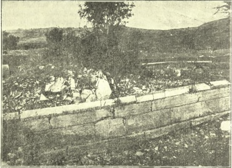
Εἰκ. 1. Δυτικὴ πλευρὰ τετραγώνου κτιρίου.
