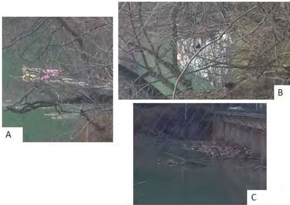
Εικόνα 10: Συγκέντρωση απορριμμάτων και κορμών δέντρων ανάντη του φράγματος του ποταμού Καλαμά (προσωπικό αρχείο).
