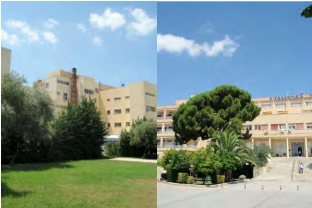
Εικόνα 65. Στην αριστερή φωτογραφία διακρίνεται η παλιά καπνοδόχος και μέρος των νέων εγκαταστάσεων, που ολοκληρώθηκαν την περίοδο των Ολυμπιακών Αγώνων. Στη δεξιά διακρίνεται η είσοδος του Σισμανόγλειου Νοσοκομείου.
