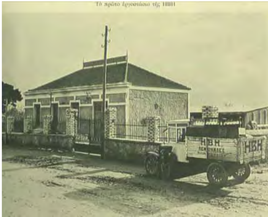
Εικόνα 47. Οι πρώτες εγκαταστάσεις της ΗΒΗ (αχρονολόγητη).
