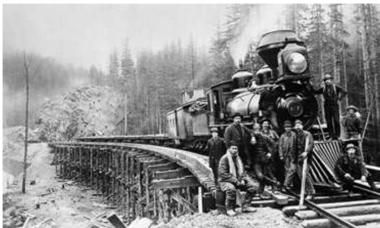
Εικ. 15 Κατασκευή σιδηροδρομικής γραμμής (τέλη 19ου αι.)
