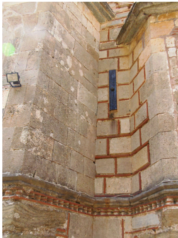
Εικ. 9:Λεπτομέρεια αρχικής τοιχοποιίας ανατολικού τοίχου (προσωπικό αρχείο)
