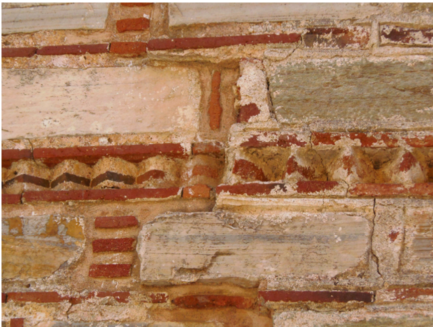
Εικ. 21:Λεπτομέρεια οδοντωτής ταινίας (προσωπικό αρχείο)
