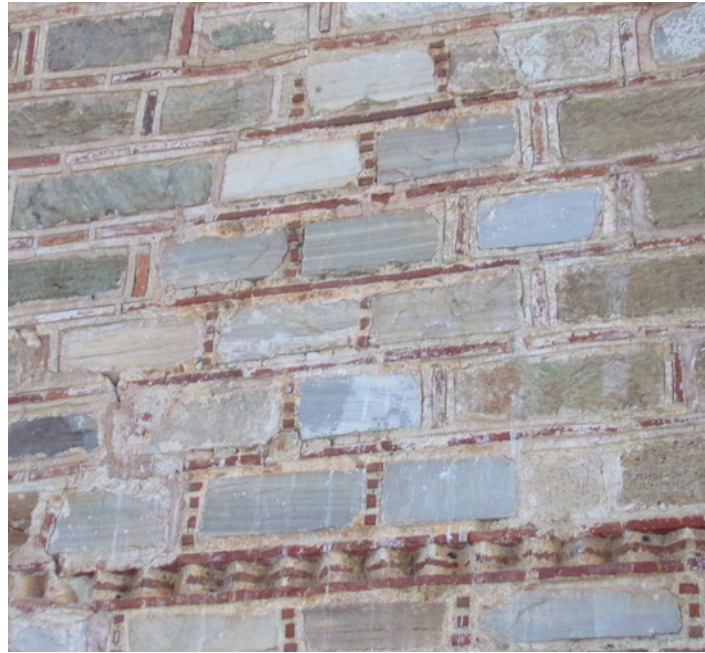
Εικ. 8:Λεπτομέρεια αρχικής τοιχοποιίας μακρών πλευρών (προσωπικό αρχείο)
