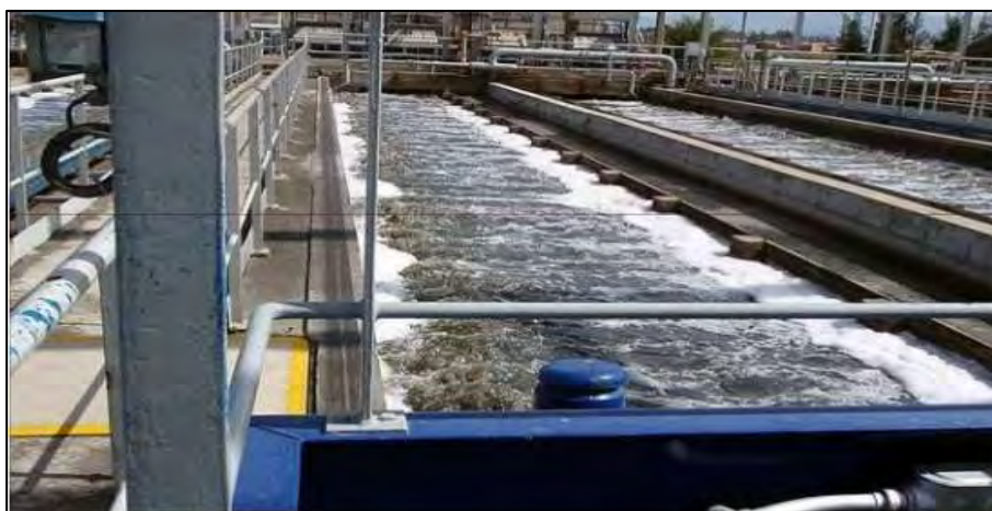
Εικόνα 3-7: Αεριζόμενος αμμοσυλλέκτης.
