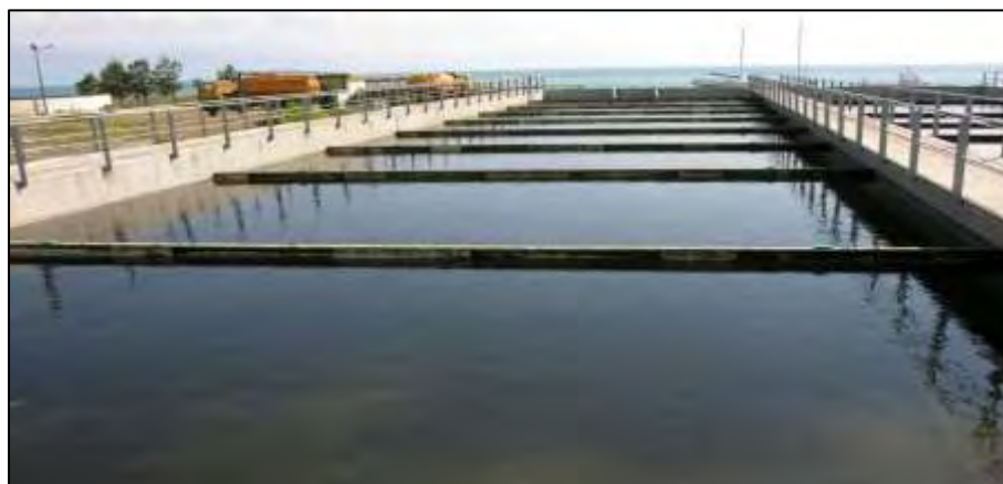
Εικόνα 3-9: Ορθογώνιες Δεξαμενές καθίζησης.
