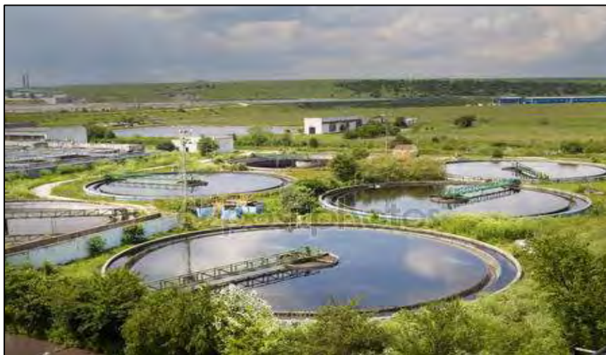
Εικόνα 3-8: Κυκλικές Δεξαμενές καθίζησης.
