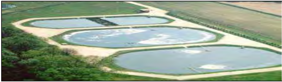
Εικόνα 3-10: Δεξαμενές και λίμνες αερισμού.
