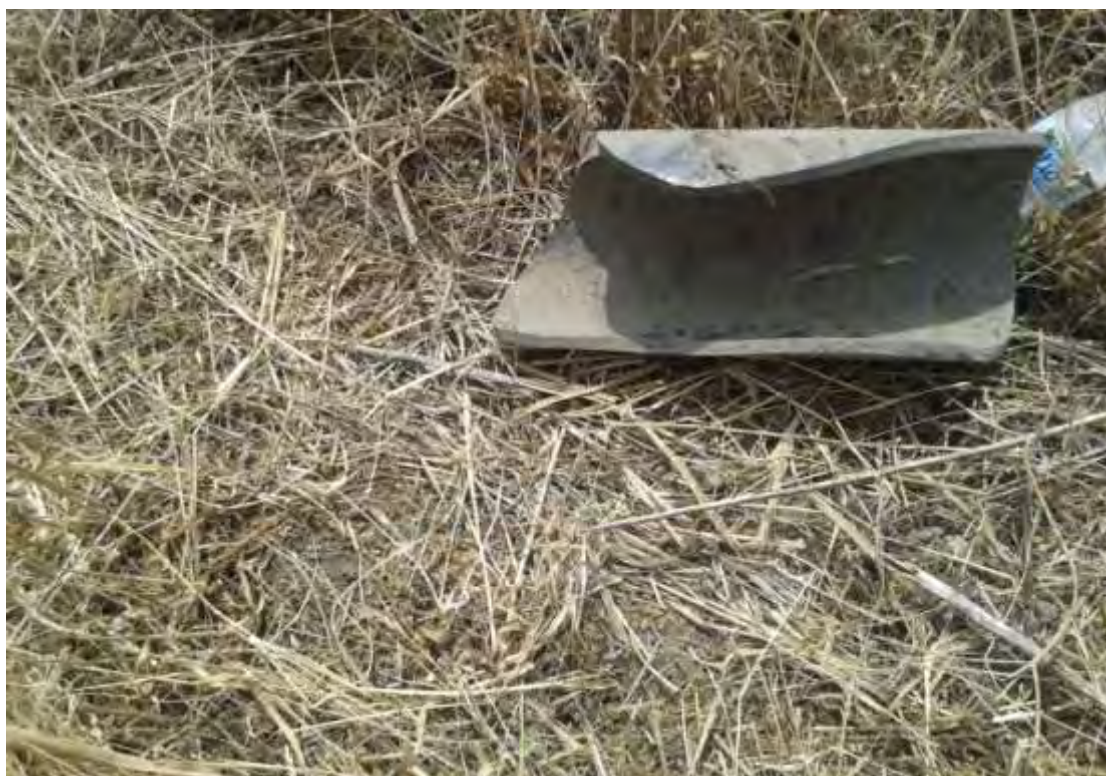
Εικόνα 5.36 βλάβη 10 η διάρρηξη αγωγού στη ζώνη Σ3
