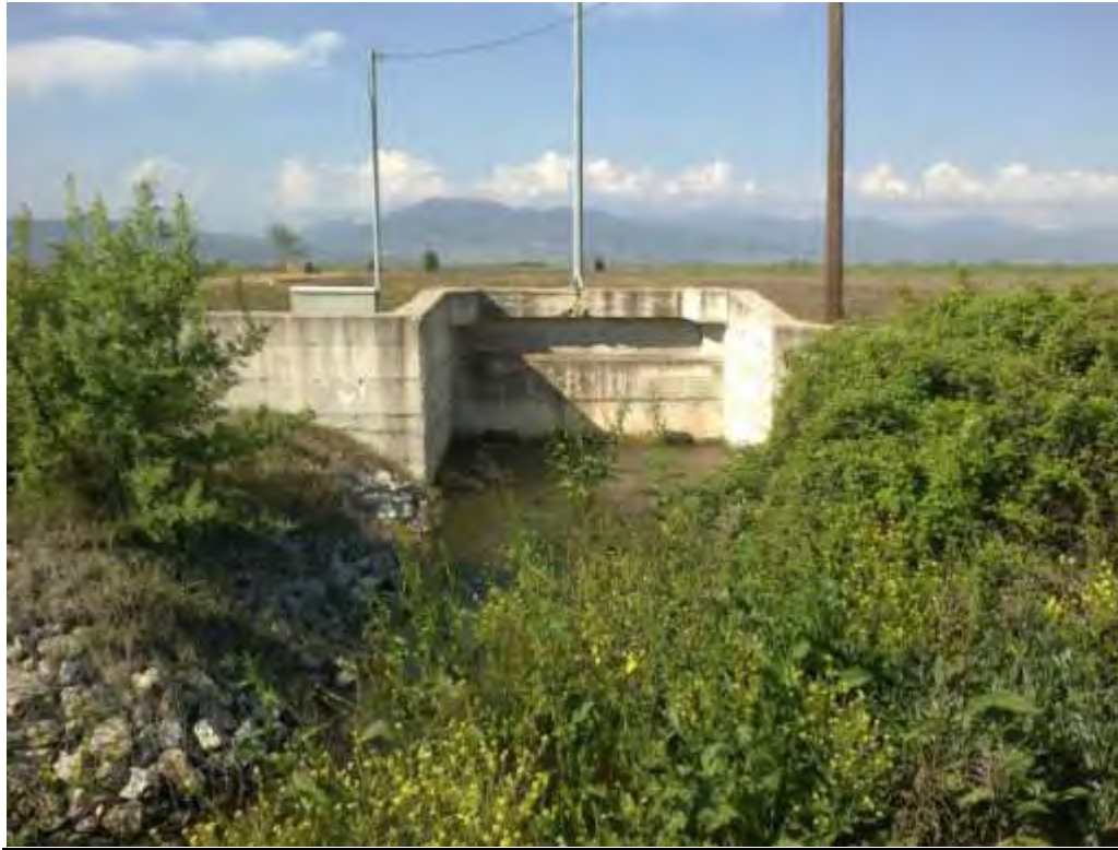
Εικόνα 4.3 εκφόρτιση ξηρορέματος
