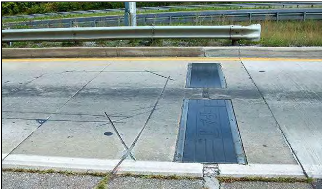
ΕΙΚΟΝΑ 5: Ανιχνευτής δύναμης κεκλιμένης πλάκας σε συνδυασμό με επαγωγικό βρόχο [26].
