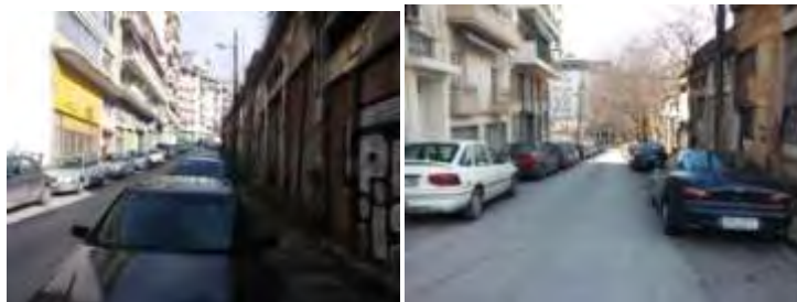
Εικόνα 19 : Παλαιά Λαχαναγορά επί της οδού Γυμνασιάρχη Μπουτάνα (φωτογραφία από έρευνα πεδίου)
