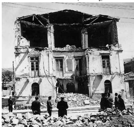
Εικόνα 3.1.2: Κατεστραμμένο σπίτι από το σεισμό του 1955 (Βόλος)
