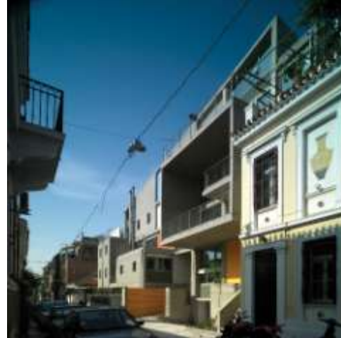
Εικόνα 3.18: Οδός Μαραθώνος και δίπλα το διατηρητέο κτίριο
