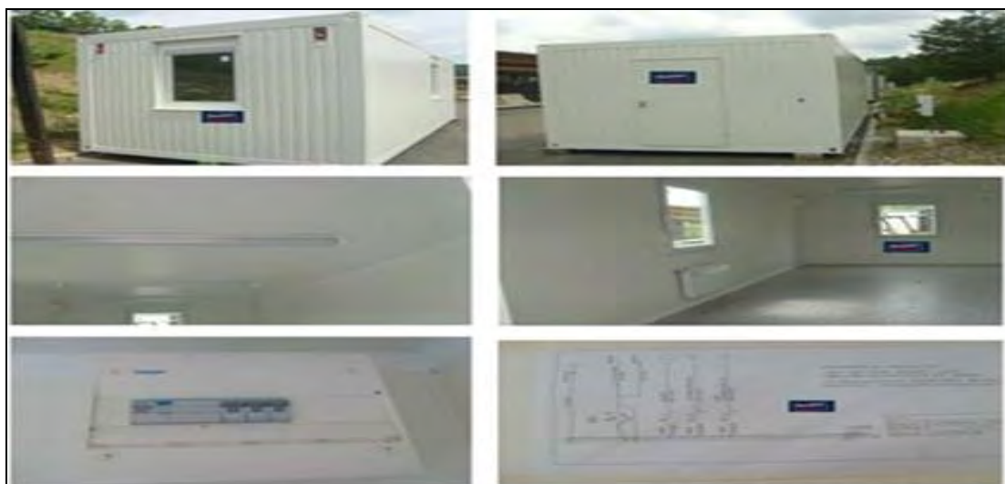
Εικόνα 4.7: Βιβλιοθήκες για το πανεπιστήμιο Ρεθύμνου στην Κρήτη (Πηγή: http://www.dmcontainer.gr/default.aspx?catid=1527 )
