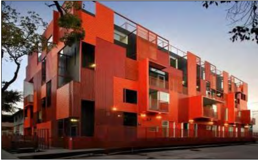
Εικόνα 3.1 : Κατασκευή από κοντέινερ στο Μπουκλιν στις ΗΠΑ ( www.multifamilybiz.com )
