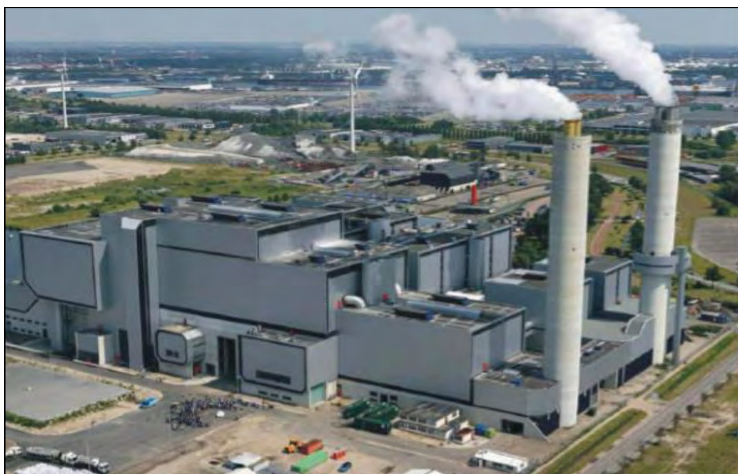
Εικόνα 3.10.: Μονάδα καύσης απορριμμάτων στο κέντρο του Άμστερνταμ (Αβανίδης, 2017).
