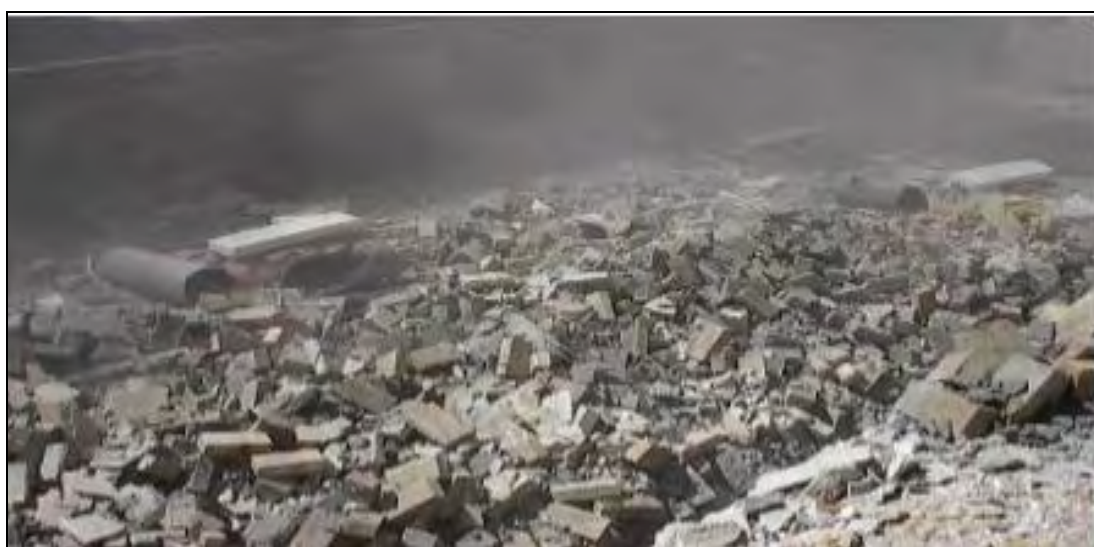
Εικόνα 2.8: Καθαρότερα απόβλητα μετά από επιλεκτική κατεδάφιση (Μπανιάς, 2009).
