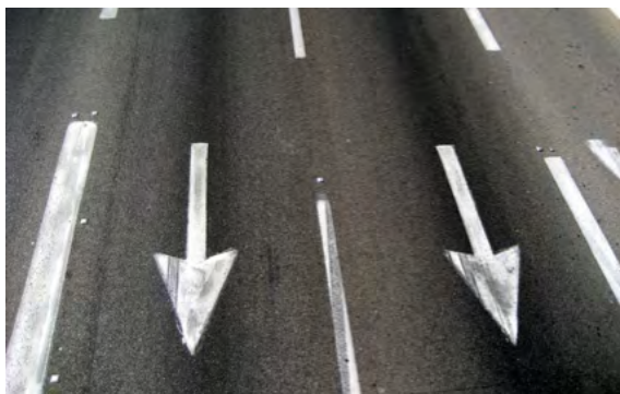
Εικόνα 22. Βέλος κυκλοφοριακής κατεύθυνσης των οχημάτων σε αυτοκινητόδρομο.
