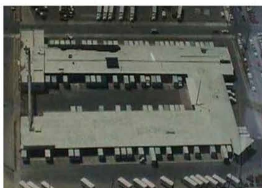
Εγκατάσταση σχήματος 'U' στο Portland, OR (Consolidated Freightways)
