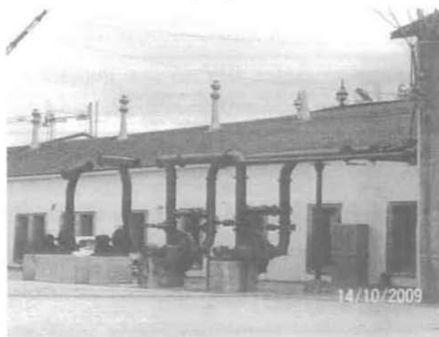
Εικόνα 21: Δείγμα του διατηρημένου κελύφους και εξοπλισμού του εργοστασίου γκαζιού
