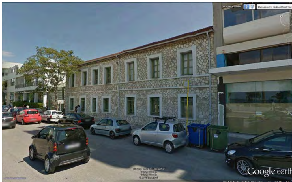
Εικόνα 5.11 Μικρά λιθόκτιστα της ΒΕΣΟ
