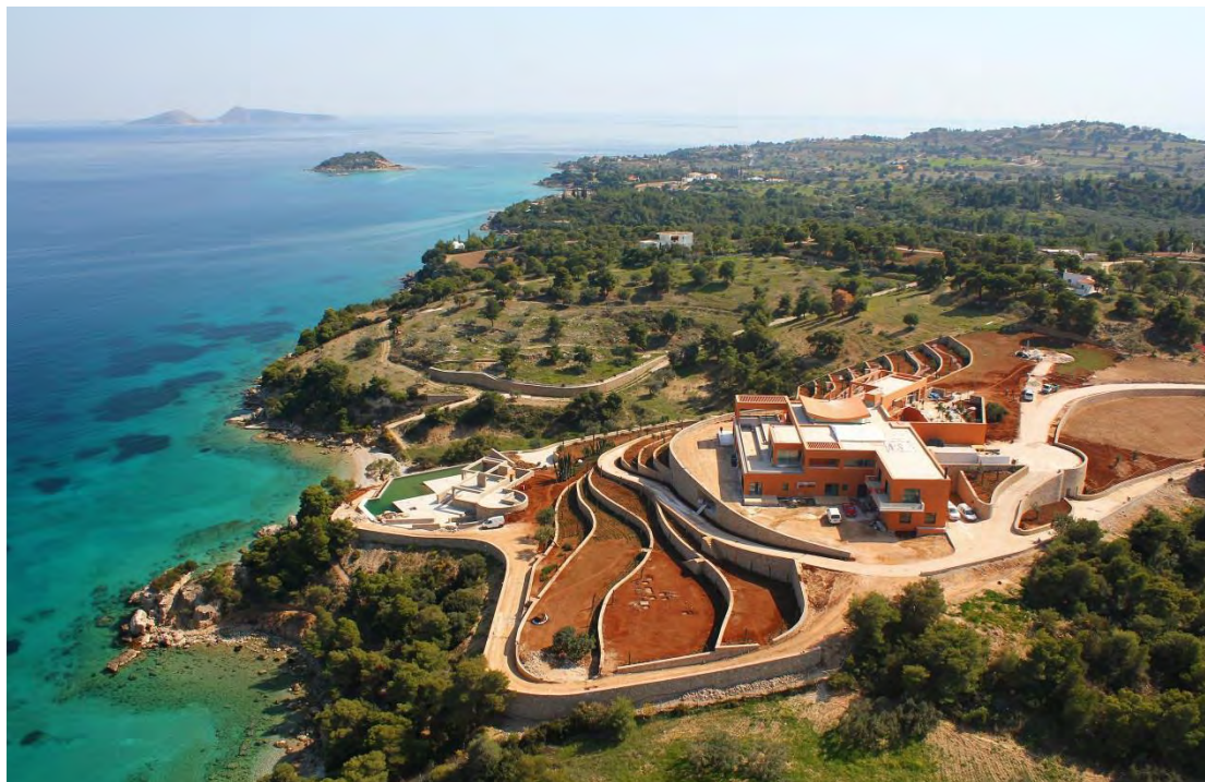
Εικόνα 21: Κατοικία μετά τον χρωματισμό των τοίχων
