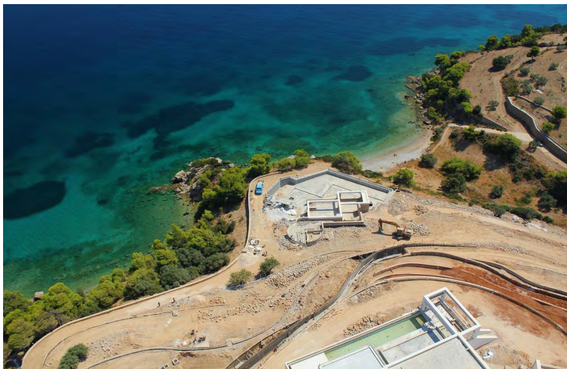
Εικόνα 22: Υπό κατασκευή Beach Club
