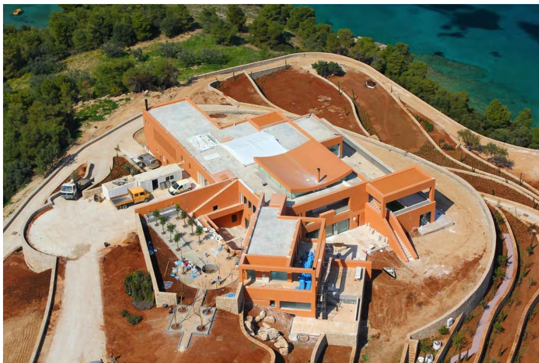
Εικόνα 7: Οι υπό κατασκευή εξωτερικοί χώροι
