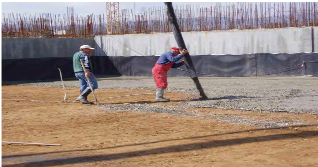
Εικόνα 3: Τοποθέτηση μπετό καθαριότητας
