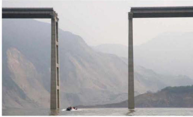
Εικόνα 1.1.5. Γέφυρα στην Wenchuan, China η οποία κατέρρευσε στον σεισμό του 2008.
