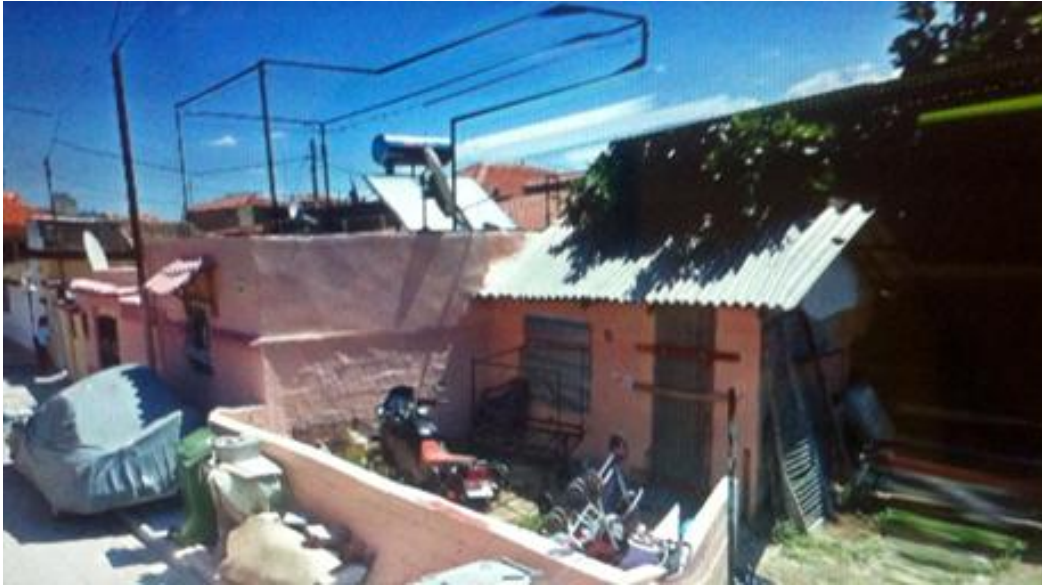
Εικόνα 3: Οικία Ρομά σε κακή κτηριακή κατάσταση
