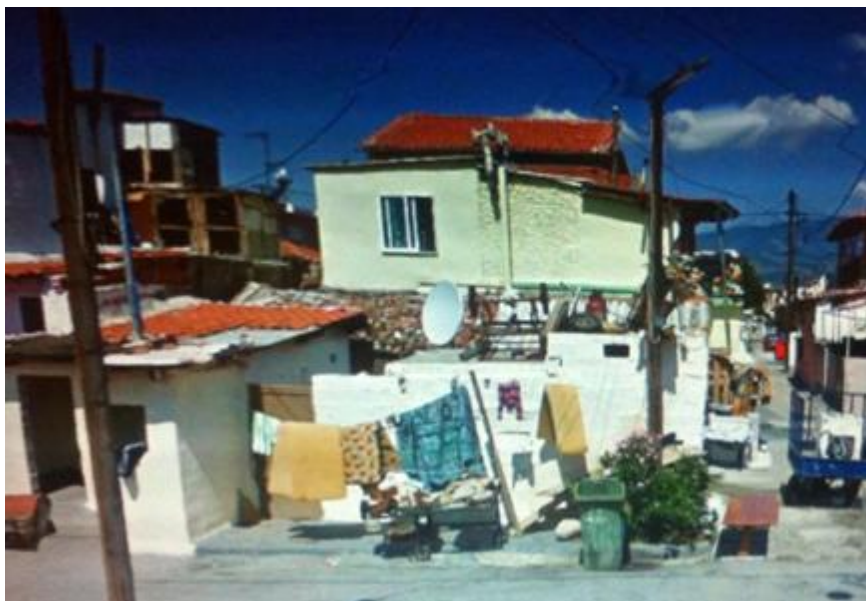
Εικόνα 2: Οικία Ρομά σε κακή κτηριακή κατάσταση
