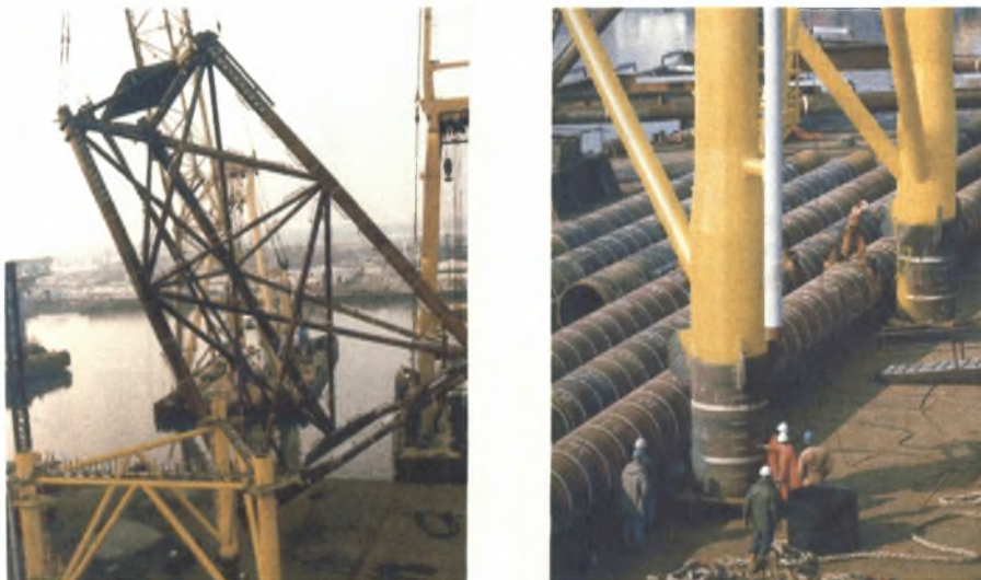
Σχήμα 2.4.8. Κατασκευή για την έδραση πλατφόρμας άντλησης καυσίμων όπου φαίνονται τα σωληνωτά μέλη της κατασκευής τα οποία καλύπτει ο API RP2A LRFD.
