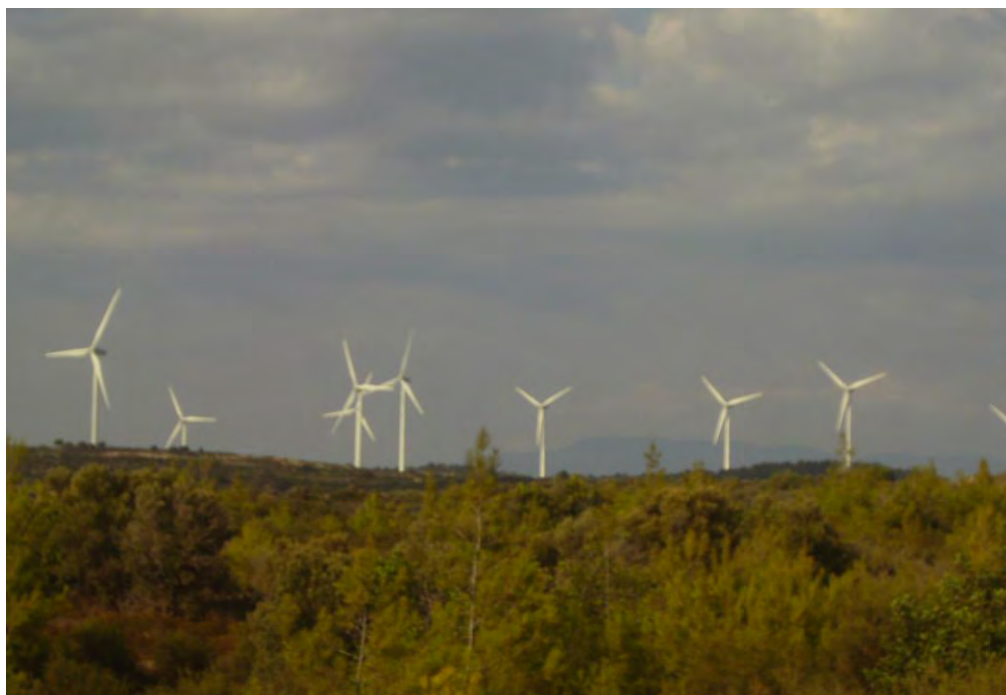
Εικόνα 5.4.1.2: Αιολικό Πάρκο στην περιοχή Ορείτες στην Πάφο, Λήψη 2
