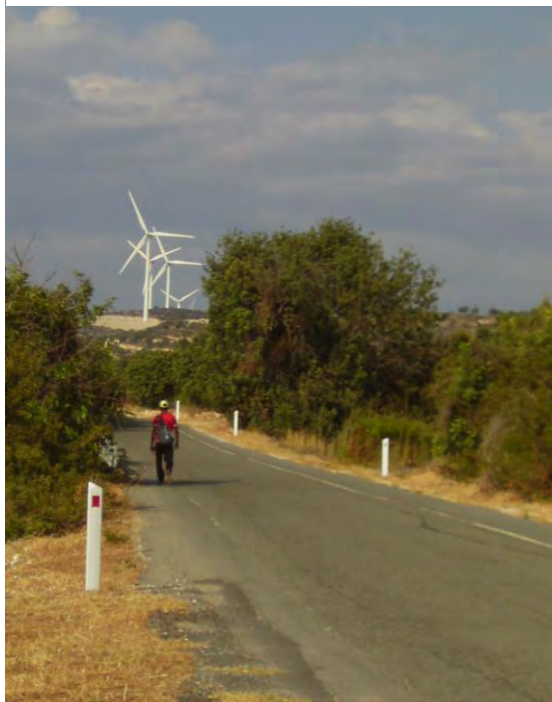
Εικόνα 5.4.1.1: Αιολικό Πάρκο στην περιοχή Ορείτες στην Πάφο, Λήψη 1
