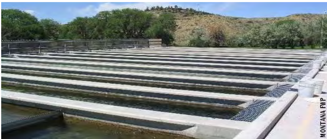
Εικόνα 7: Τσιμεντένιες δεξαμενές (raceways) (πηγή: http://fwp.mt.gov/ )
