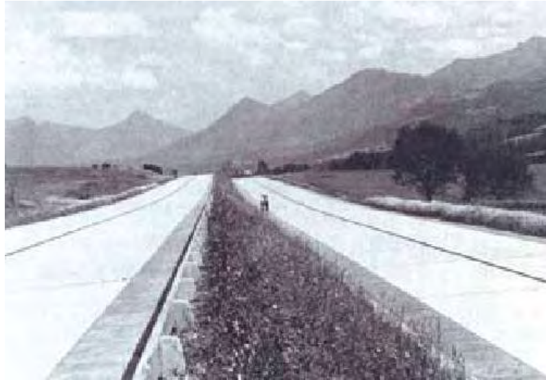
Ξύλινα στηθαία ασφαλείας με πασσάλους από οπλισμένο σκυρόδεμα στον αυτοκινητόδρομο του Μονάχου (Irschenberg)
