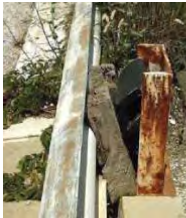
Στηθαία με πλάκα έδρασης σε τεχνικό έργο και παρεμβλήματα από ξύλο και ελαστικό
