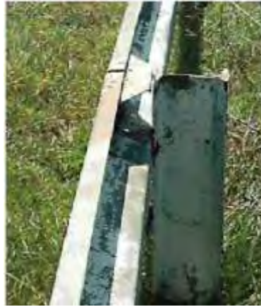
Στηθαία με έμπηξη ορθοστάτη και χαλύβδινο παρέμβλημα
